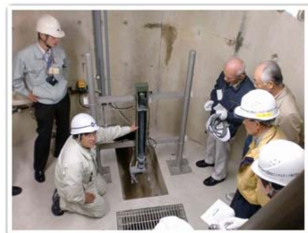
▲下水道施設見学会（計装人孔）
