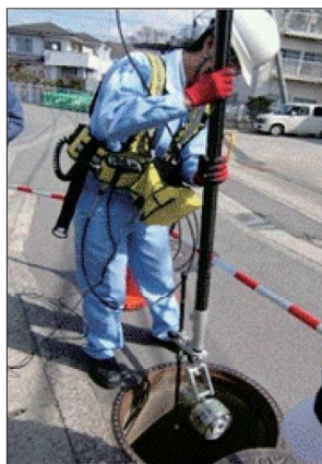
管口カメラ調査の実施例
