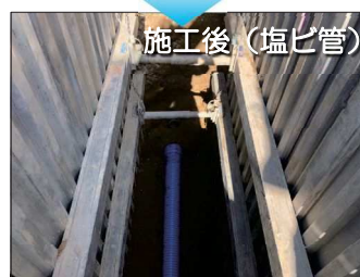
管路施設改築の施工前後
