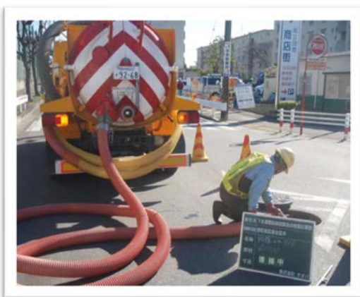
写真3-3.管路施設の清掃・点検
