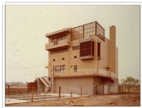
写真2-2.落合ポンプ場（建設当時）
