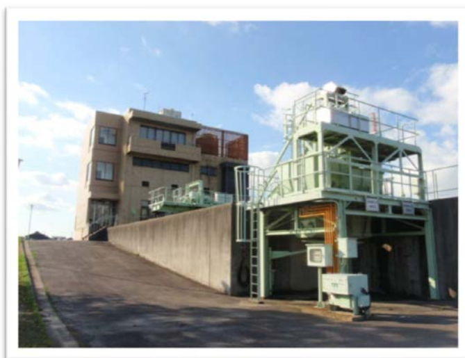
写真 2-6.落合ポンプ場（外観）
