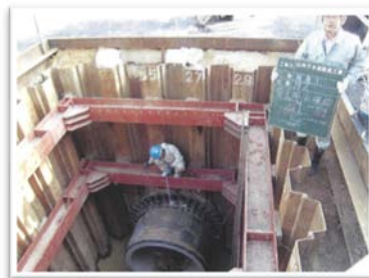
▲雨水管推進工事の様子
