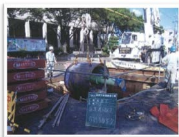
▲雨水管推進工事の様子
