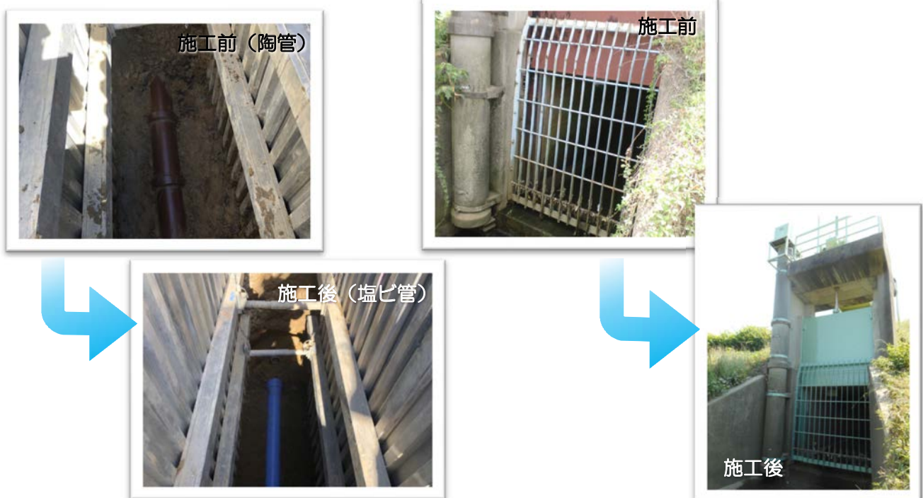
写真 3-5.管路施設改築の施工前後（昭和地区）
