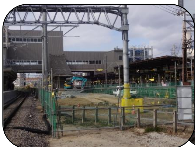
仮6番線ホームの工事状況
