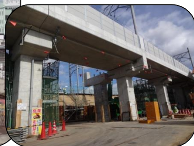
仮高架橋の工事状況
