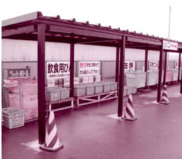
だいいち ふ ねんぶつしょ り じょう 第一不燃物処理場
