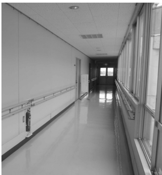
廊下の整備例：両側に2段の手すりを設置。主な部屋の入口付近の手すりには点字シールが貼られ、視覚障がいのある人への配慮がある。 (市内福祉の里八ツ田)
