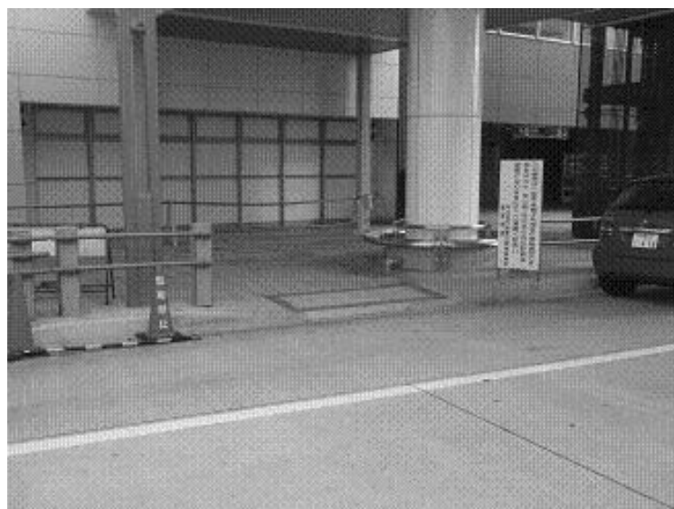
送迎スペースの整備例：車いす使用者等が利用しやすいよう、すりつけを施した送迎スペース。（名古屋市鳴海駅）
