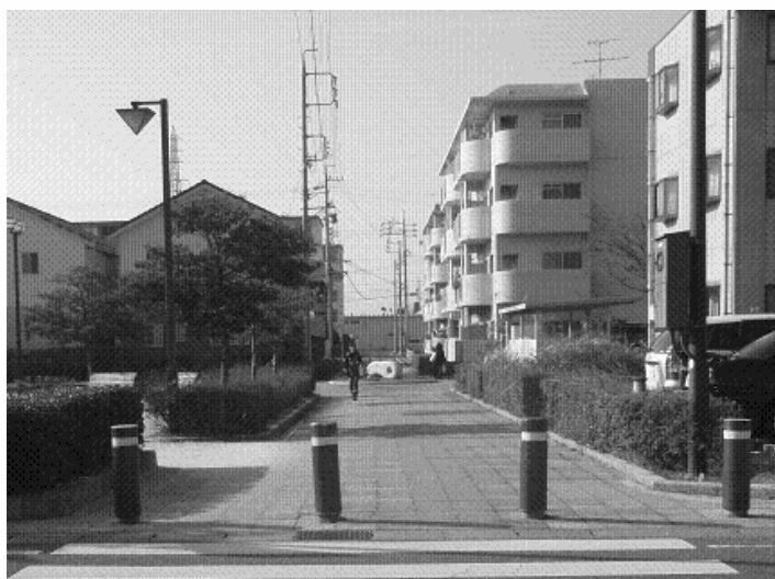
自転車歩行者専用道の整備例：車が進入できないよう車止めを設置。カラー舗装で周辺道路と区別。植栽を施し景観にも配慮している。(市内番割公園西)
