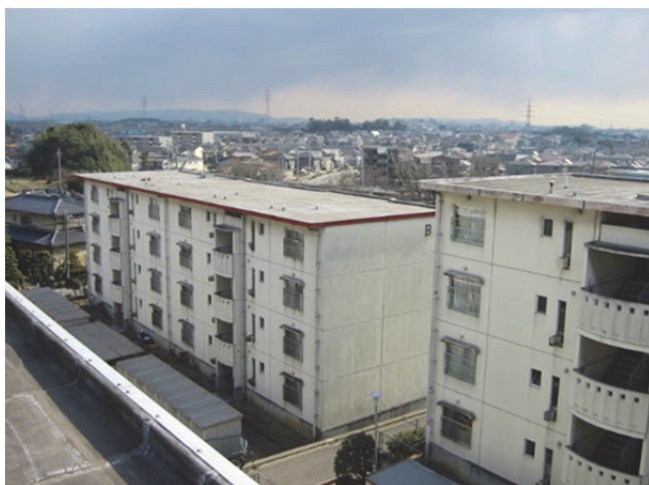
市営八橋住宅（昭和 54～57 年度建設）
