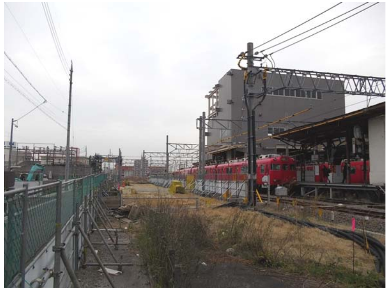
仮ホーム設置箇所（平成25年3月25日撮影）
