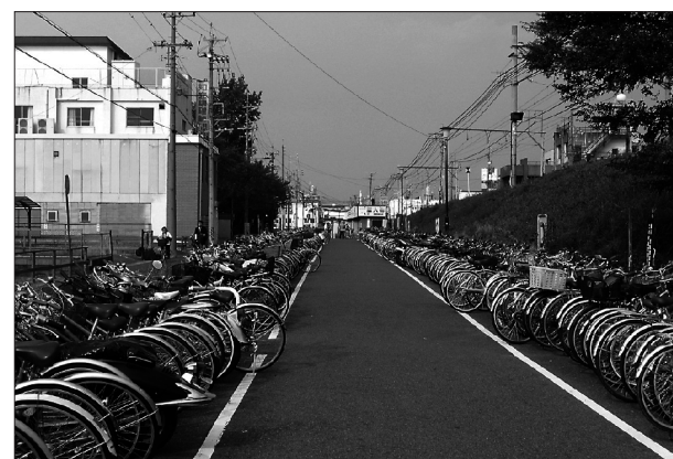
明治用水管路の上部利用（駐輪場）
