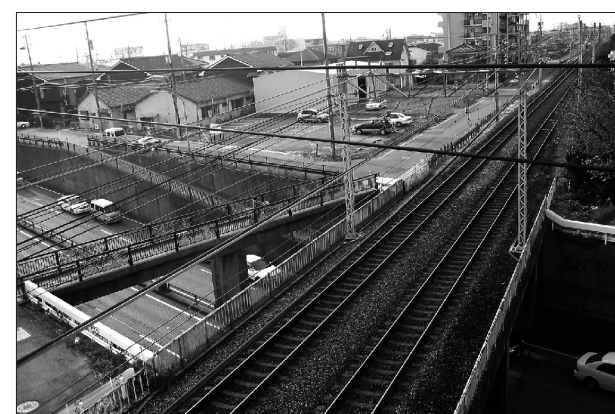
国道155号線に架かる歩道橋
