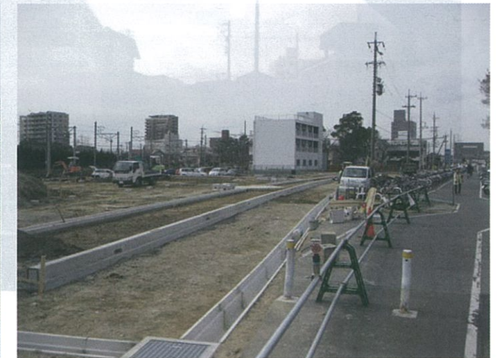
仮側道・仮駐輪場工事状況（2月28日撮影）
