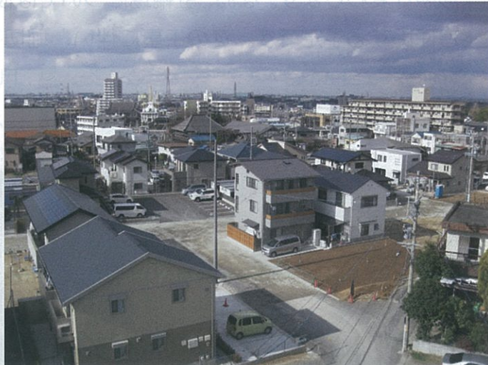
【家屋移転状況】
