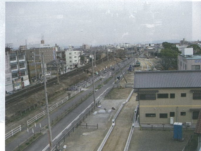
仮側道工事状況（2月28日撮影）
