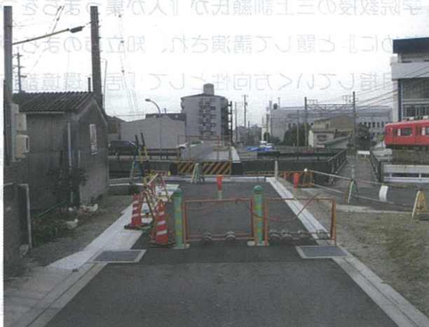
仮歩道橋の架設状況（2月28日撮影）
