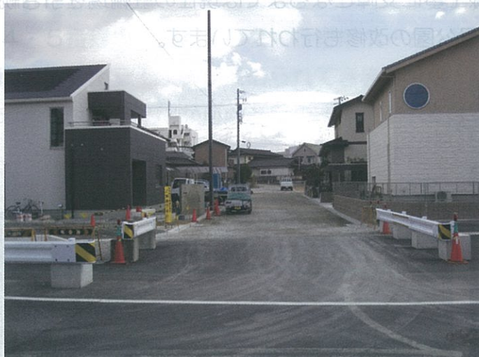
【区画道路整備状況】
