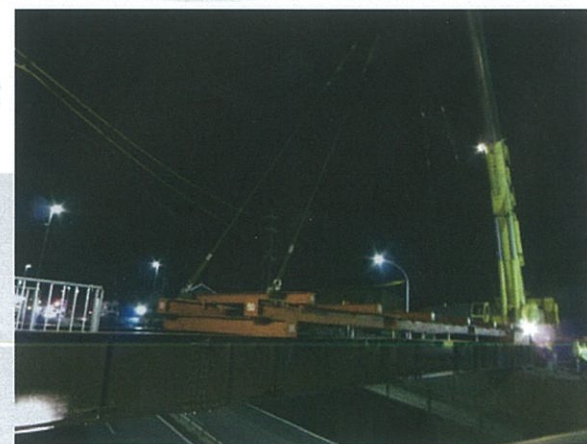
夜間工事（2月12日撮影）
