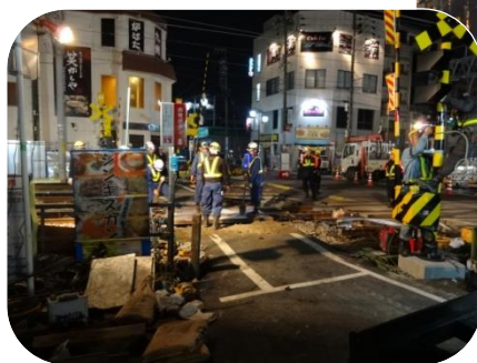
歩道工事の様子
