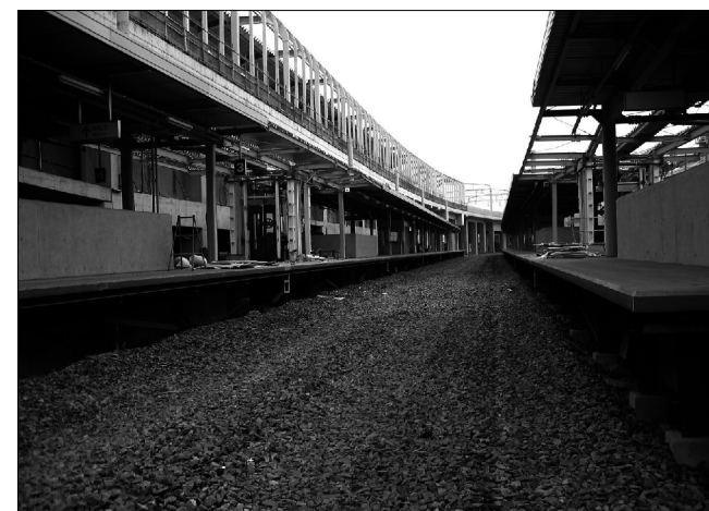
除却中の仮駅舎
