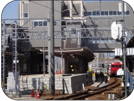
仮4・5番線ホームの工事状況
