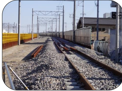
名古屋本線仮線軌道敷設工事状況
