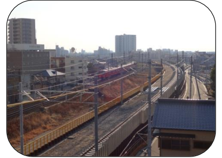
名古屋本線仮線の工事状況
