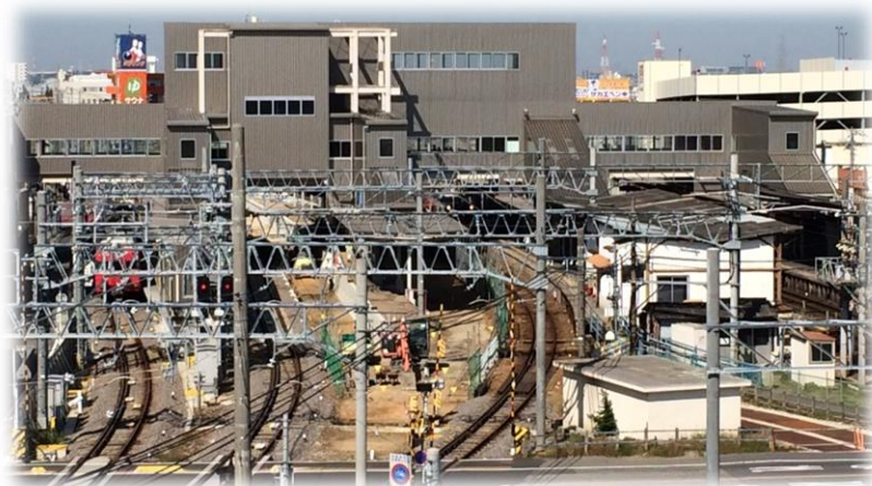
現在の仮跨線橋（全景）
