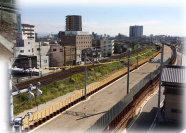
②仮線の工事状況
