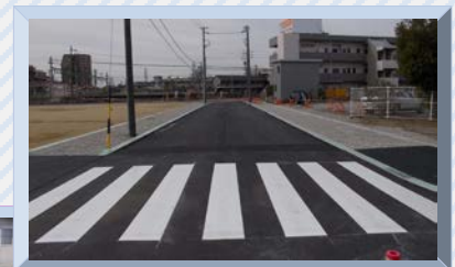
道路築造工事 (区画道路12-1号線)
