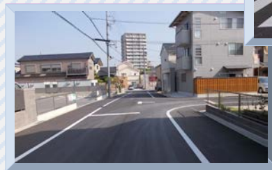
舗装工事 (区画道路8-2号)
