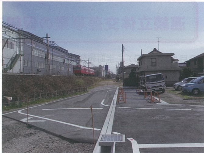
仮側道の状況（平成 25 年 2 月 14 日）
