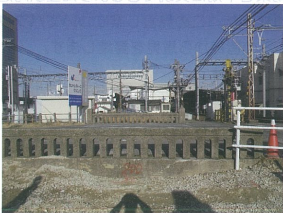
見透橋撤去前（平成 25 年 2 月 5 日）
