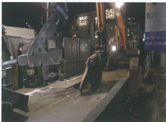
見透橋撤去工事状況（平成 25 年 2 月 6 日）
