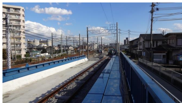
国道155号線 仮架道橋
