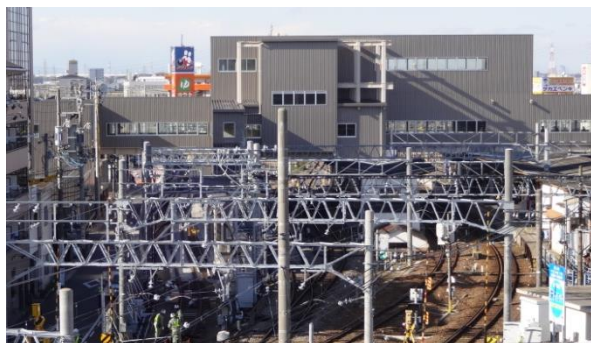
仮跨線橋（全景）
