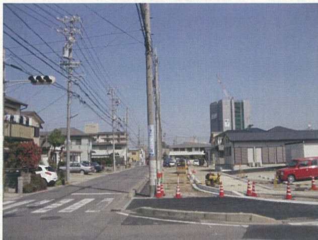
【宝町線歩道設置工事】
