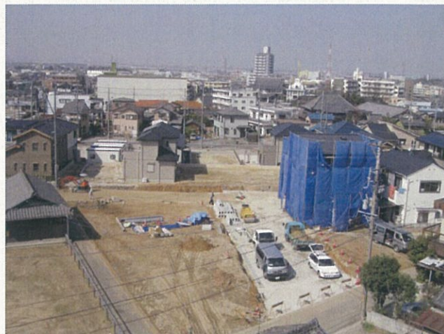
【移転整地・区画道路設置工事】
