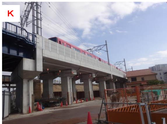
K 仮高架橋（三河線交差部付近）
