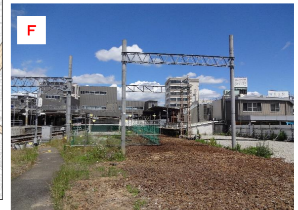
F 知立駅旧名古屋本線(既設線撤去工事中)
