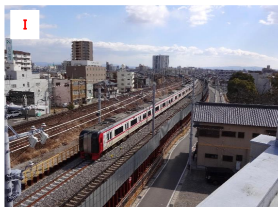
I 名古屋本線と仮線
