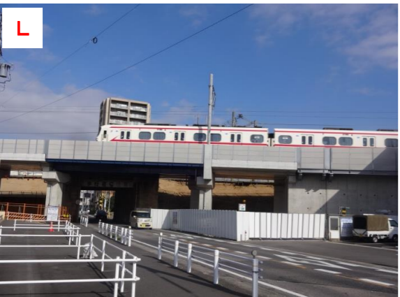
L 仮高架橋（県道安城知立線交差部）
