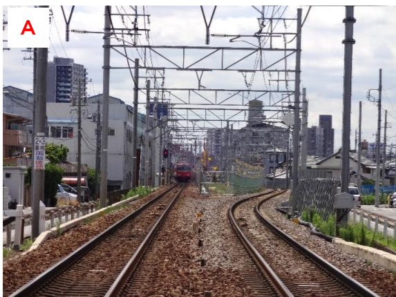
A 名古屋本線からの仮線への分岐（一ツ木方面より）
