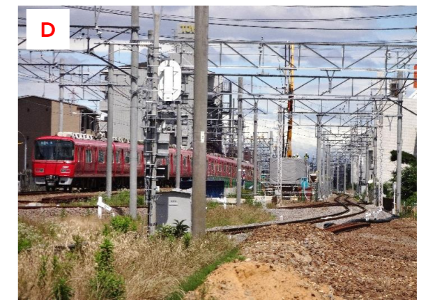
D 知立2号踏切付近より一ツ木方面を望む(本体工事施工中)
