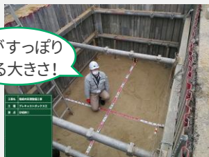
①道路を掘削
