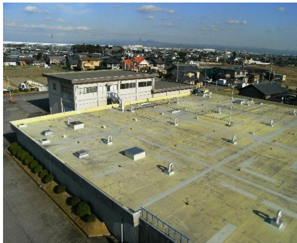
▲配水池 (手前)、管理棟 (奥)
