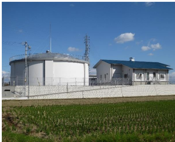
▲配水池 (左)、管理棟 (右)
