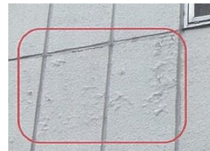
ALC 等 部分塗替、欠損箇所の 修復、目地部分補修等
