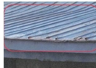
金属屋根等 腐食箇所の部分塗 替、部分取替等
