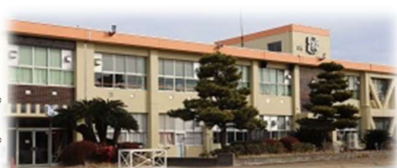
外壁も新しくしました！（R3知立小学校）
