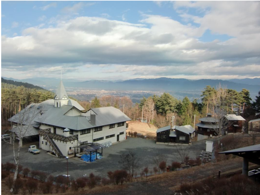
管理棟とケビン棟全景
