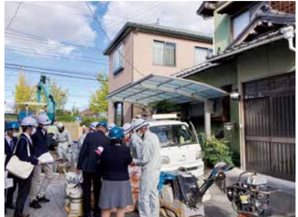
10月20日 建設水道委員会で所管施設巡視を行いました。(昭和地区下水管耐震工事、道路工事事業他)
