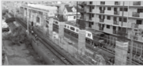
線間施工部の様子(H30.12月撮影)
