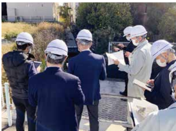
11月9日 建設水道委員会の管内巡視を行いました。(長田排水路改修工事、他見学)
