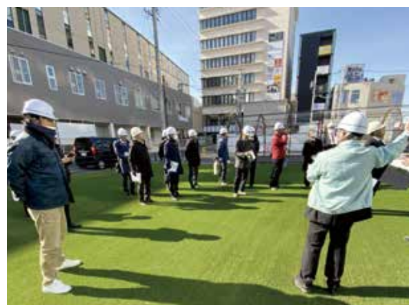
2月8日 知立駅周辺特別整備委員会にて、知立駅周辺整備事業の進捗状況について現地視察を行いました。
