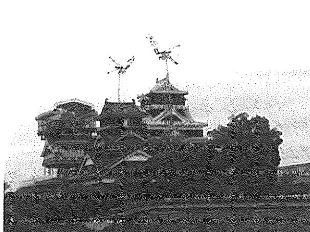
熊本城 修復工事
