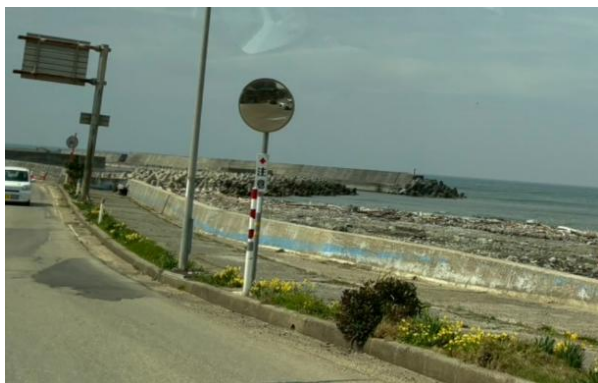
海底にあった岩とテトラポットがむき出し
