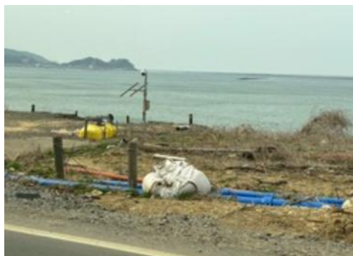
青い管は上水道と思われる。 埋設すると時間も費用もかかるため置いたまま
