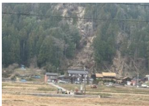
土砂崩れが民家のすぐ裏にまで迫る
