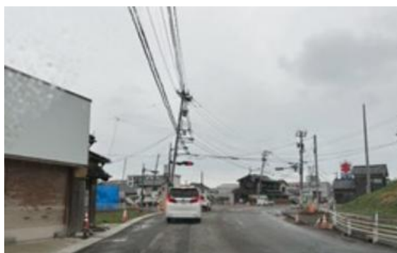
傾いている電柱(ここだけではない)
