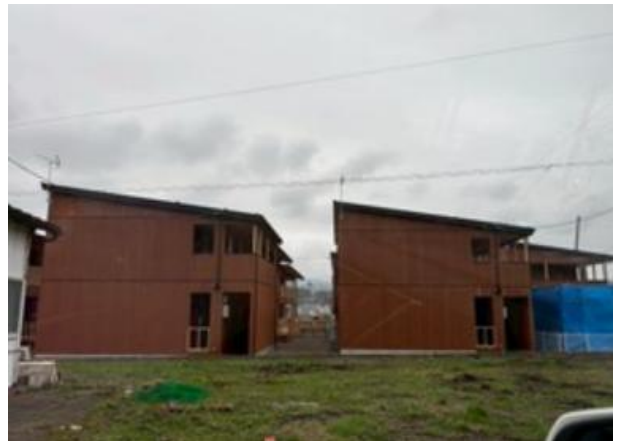
仮設住宅 プレハブとは思えないほどきれいなつくり
