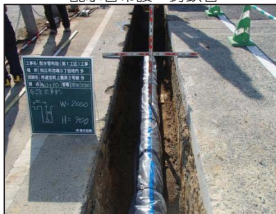
配水管布設 鋳鉄管
