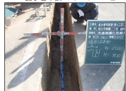
配水管布設 ポリエチレン管
