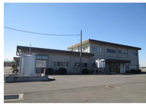
八橋配水場 (管理棟)
