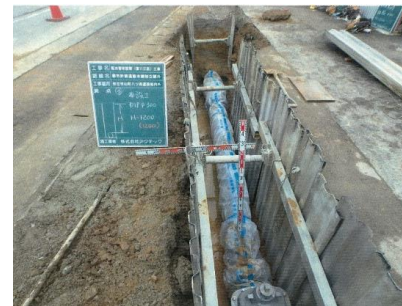
道路事業関連布設
