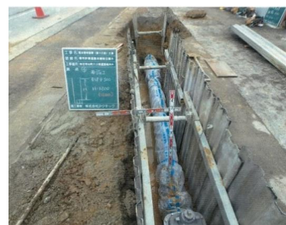
道路事業関連布設
