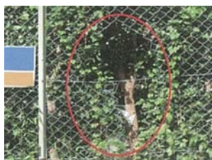
外構フェンス等 欠損、腐食、傾斜箇所 の部分取替等
