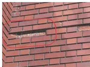
外壁タイル等 タイル剥落箇所の部分 復旧、目地部分補修等
