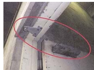
内装建具等 不具合箇所や異常箇所 の部分取替等
