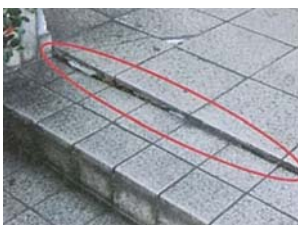
通路等 段差や沈下箇所の部分 修繕等
