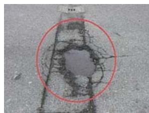
舗装等 陥没や欠損箇所の部分 修繕等
