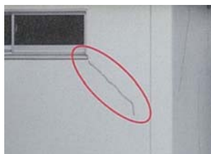
塗装仕上げ等 ひびわれ補修、鉄筋露 出部の断面修復等
