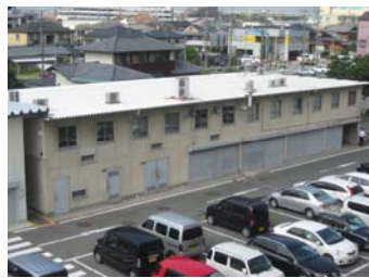
写真 現業棟の全景
