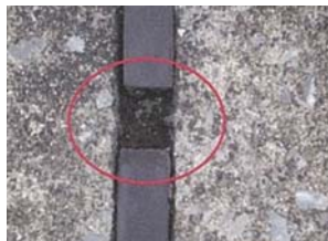
保護防水押さえコン等 目地材の部分取替、押 さえコンの部分修繕等
