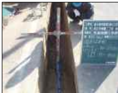
配水管布設 ポリエチレン管（広見地区） 配水管布設 鑄鉄管（市道中央通線）
