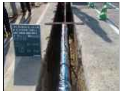
配水管布設 ポリエチレン管（広見地区） 配水管布設 鑄鉄管（市道中央通線）
