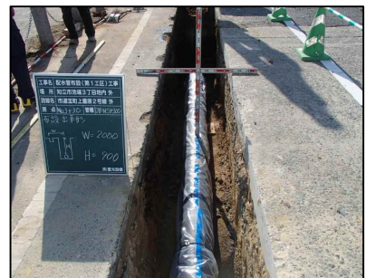
配水管布設 ポリエチレン管（広見地区） 配水管布設 铸铁管（市道中央通線）
