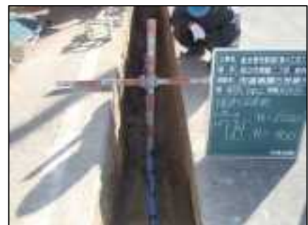
配水管布設ポリエチレン管
