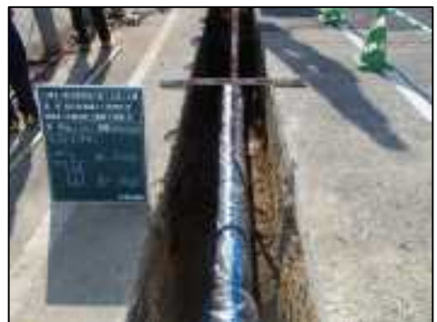
配水管布設 鋳鉄管
