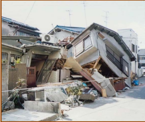
木造家屋1階の倒壊 阪神・淡路大震災／平成7年（1995年） 写真提供：応用地質株式会社
