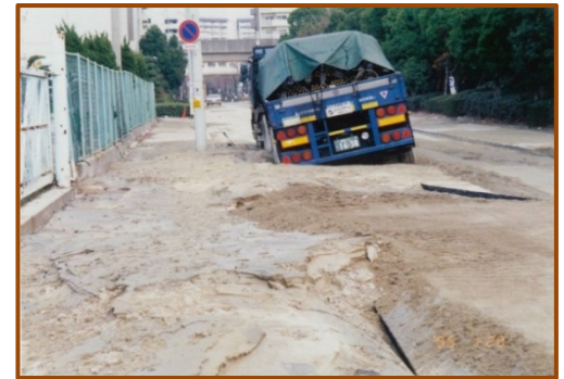
道路にめり込んだトラック 阪神・淡路大震災／平成7年（1995年） 写真提供：応用地質株式会社
