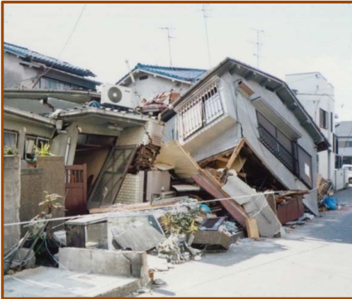
木造家屋1階の倒壊 阪神・淡路大震災／平成7年（1995年） 写真提供：応用地質株式会社
