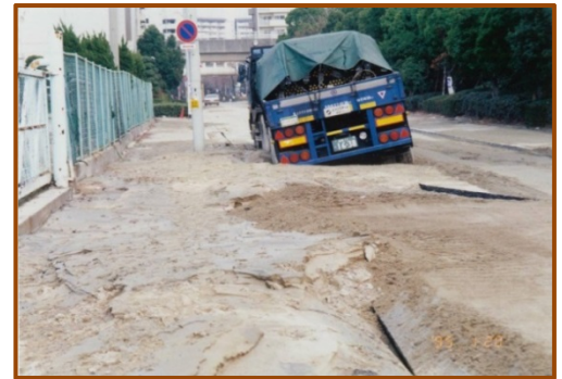
道路にめり込んだトラック 阪神・淡路大震災／平成7年（1995年） 写真提供：応用地質株式会社
